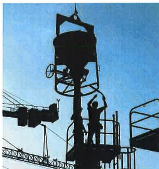
Im Baugewerbe werden Leiharbeiter nach wie vor stark nachgefragt.
